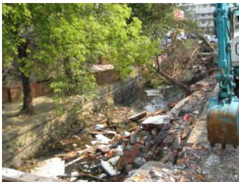
整修中護城河(2008)
