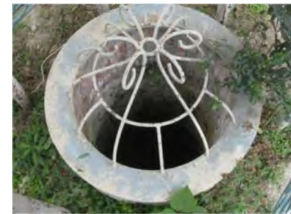
舊城古興隆井現地照片
