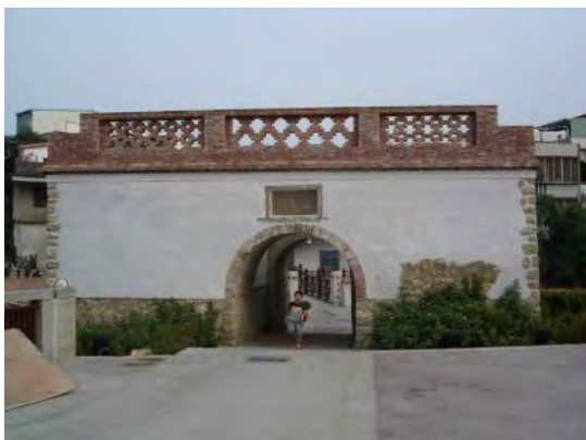
修復後之東便門
