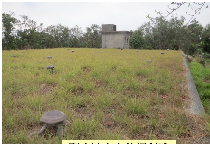
配水池上方的通氣孔
