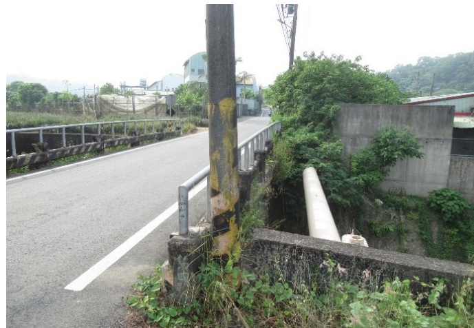
大樹興山路第四號橋的海軍水管(白漆鐵管)
