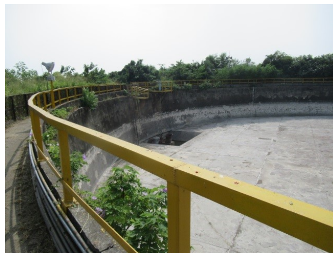
半屏山工業用配水池(7,500噸露天配水池)
