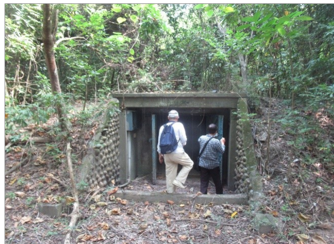
RC覆土式的過濾池
