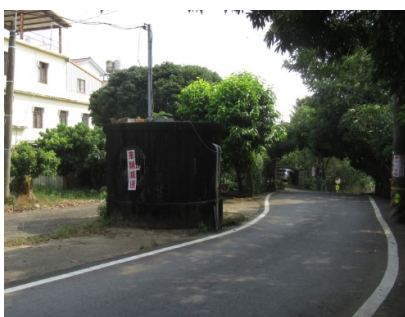
幹管量水器室
