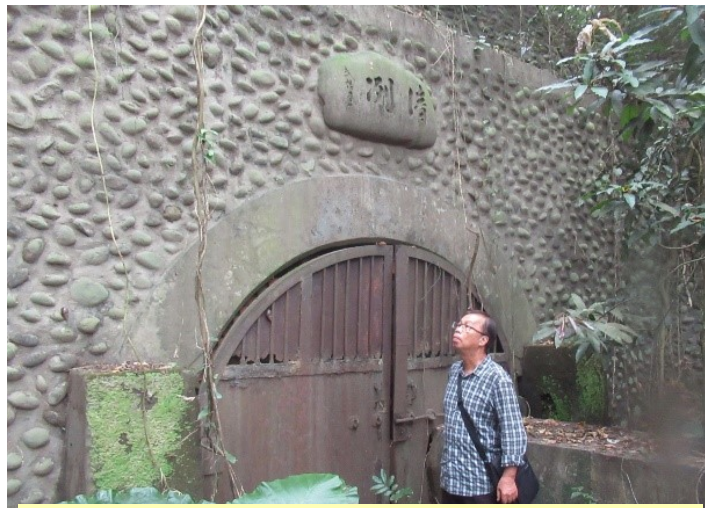
導水管隧道東側入口的卵石砌擋土牆
