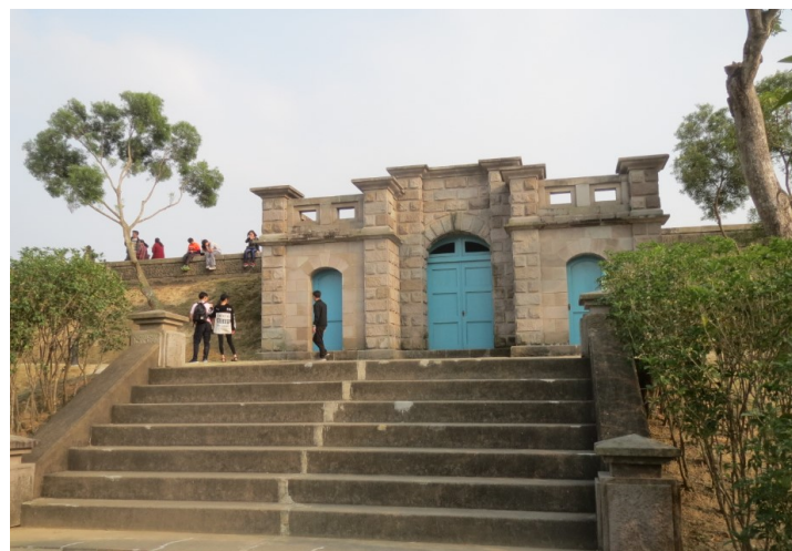
台南水道淨水池
