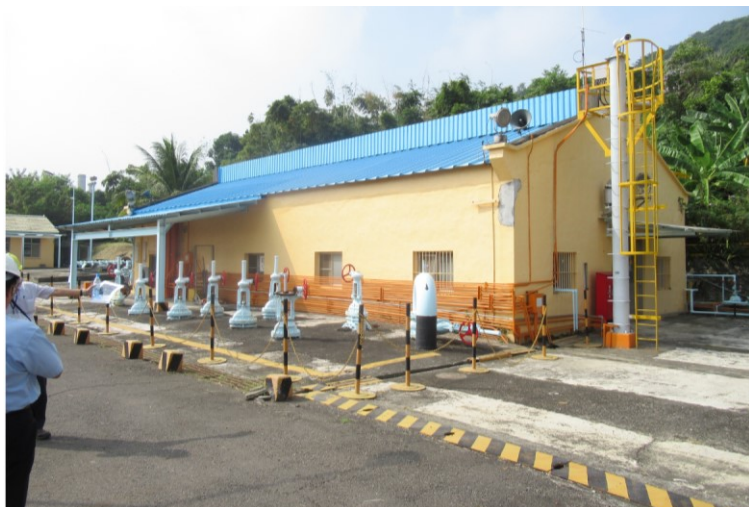
高雄煉油廠揚水第一泵房
