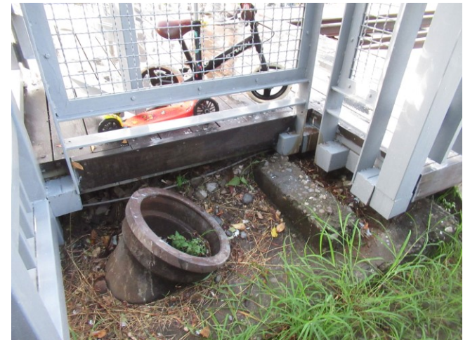
大樹舊鐵橋的阿緱水道水管殘跡
