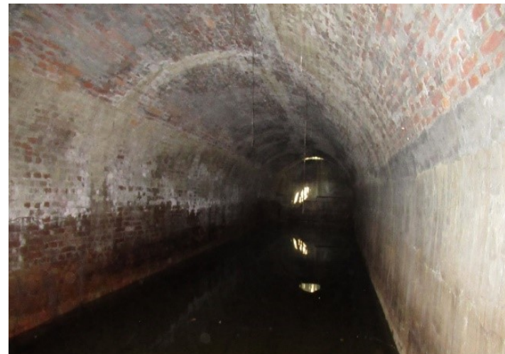
凹底山配水池內部(1944年竣工)
