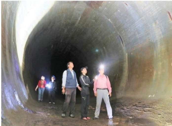
半屏山配水池的內部空間
