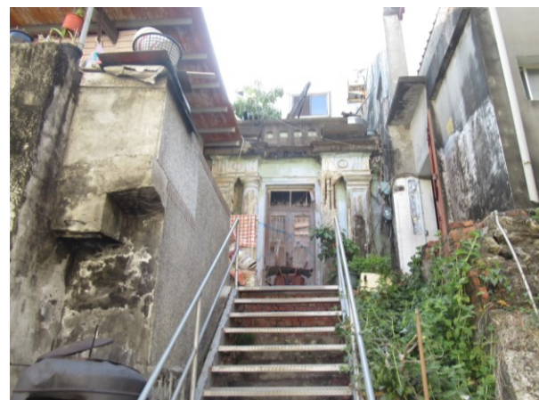
打狗水道量水器室(鼓山一路53巷)
