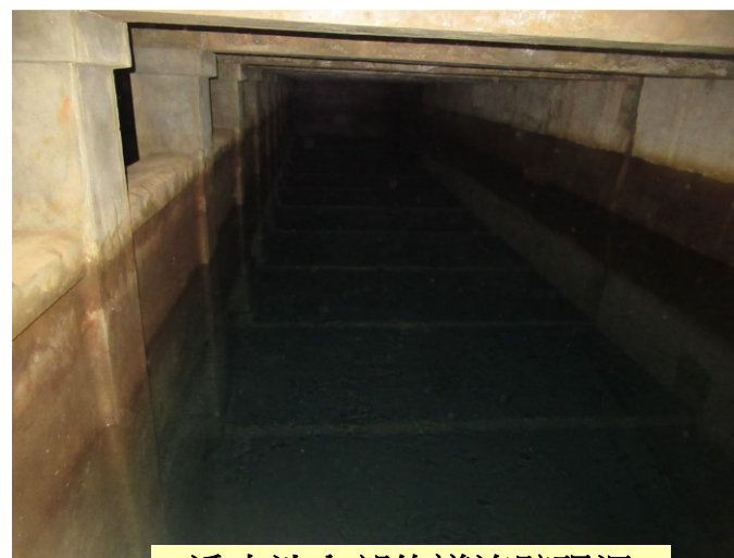
淨水池內部的導流壁現況
