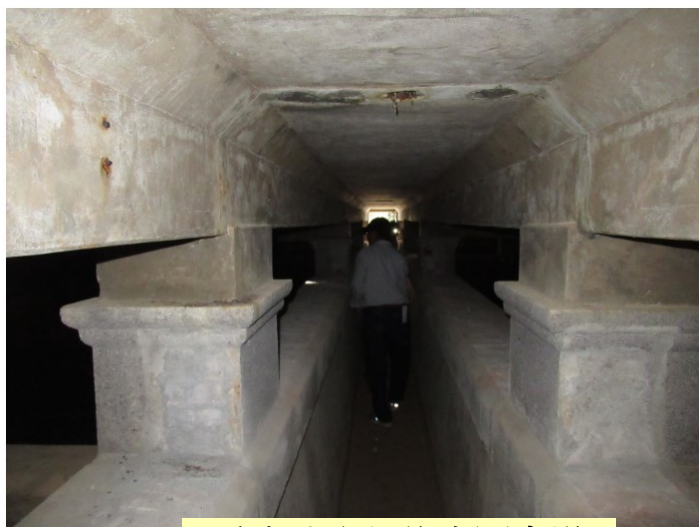
淨水池內部的中間走道
