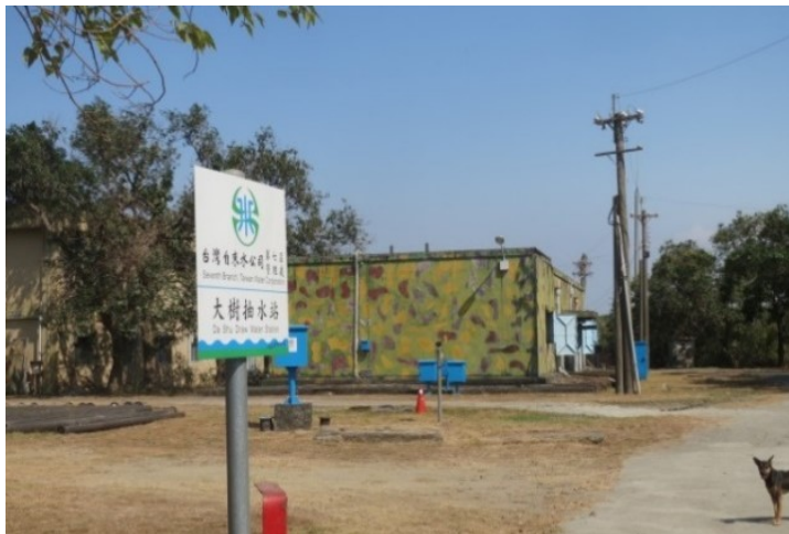
大樹取水站的唧筒所，設防爆鐵門
