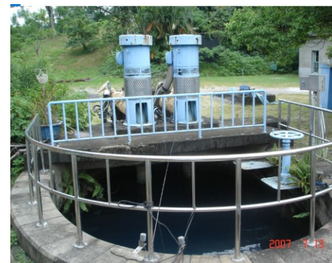
打狗水道的集水井
