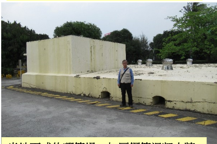
半地下式的唧筒場，加厚鋼筋混凝土牆
