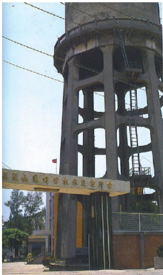
鳳山光復路的水源地及高架水塔
