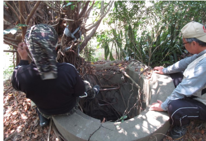
凹底山配水池入口(1944年竣工)
