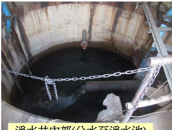
淨水井內部(分水至淨水池)
