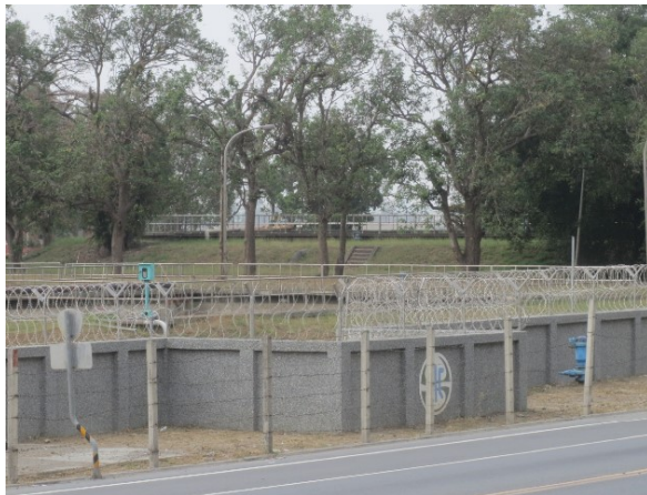
淨水場的過濾池
