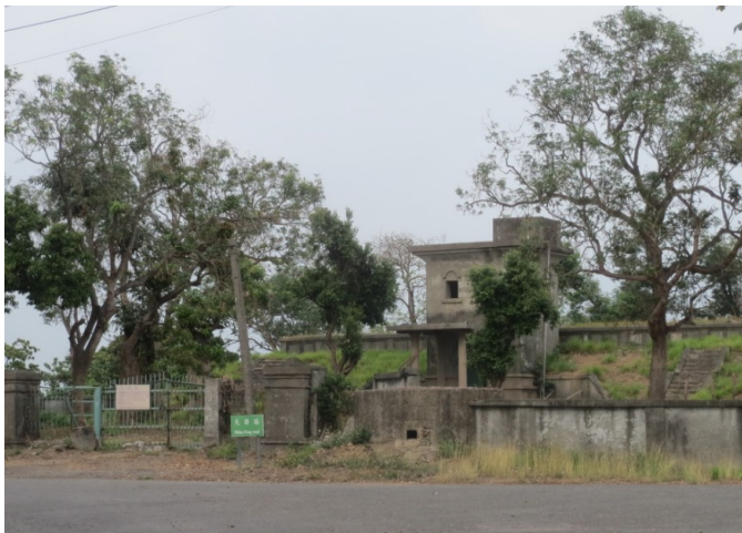
步校訓練場內的拷潭配水池(1942年竣工)
