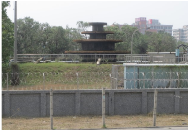
翁公園淨水場的氣曝池
