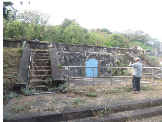
瓣井室位置(外部建物已拆)
