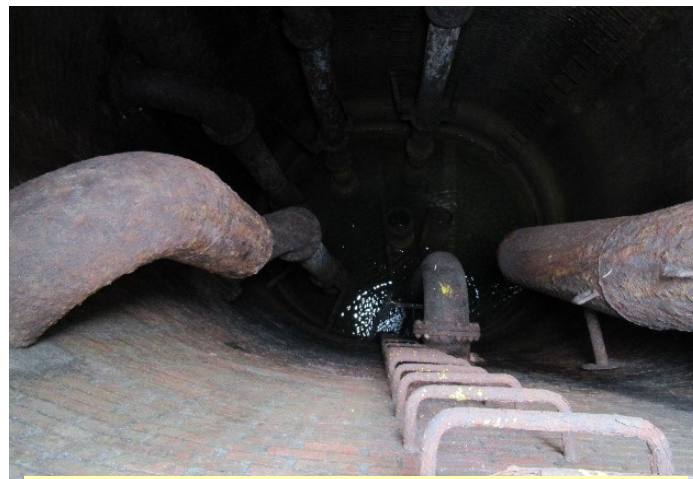
水井內部，磚造井壁、鑄鐵管及爬梯
