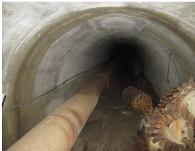
隧道內管徑60公分鑄鐵管(送水管)
