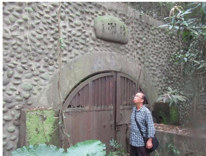
導水管隧道東側入口的卵石砌擋土牆
