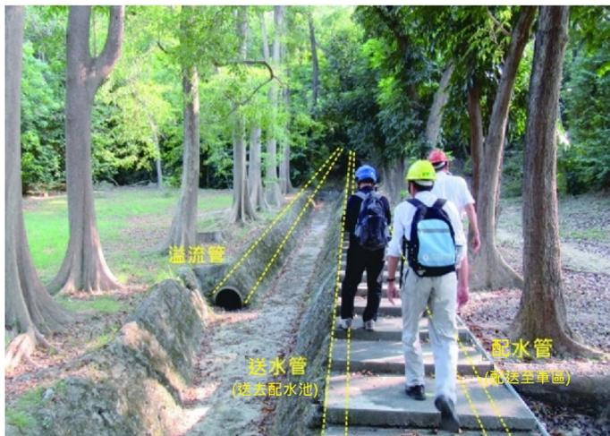
登山步道的配水管、送水管、溢流管
