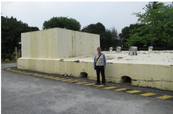
半地下式的唧筒場，外部為加厚的鋼筋混凝土牆
