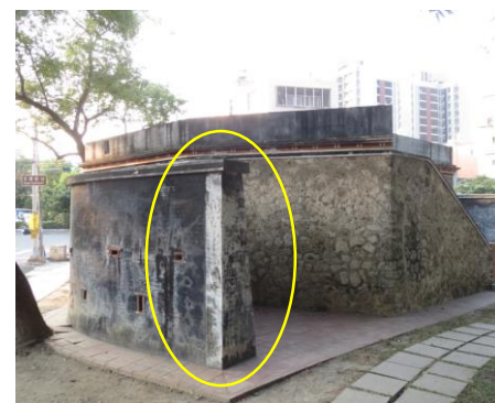
澄瀾砲台旁的土牆
