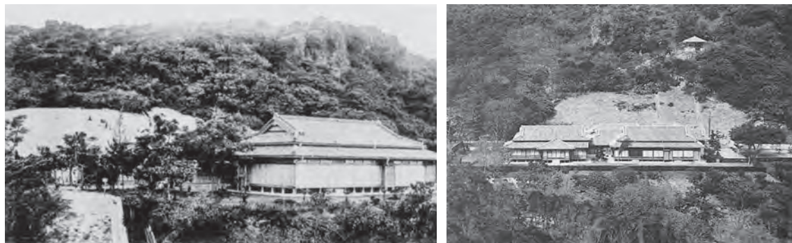
圖 3-2 日治時期的貴賓館及壽山館照片
