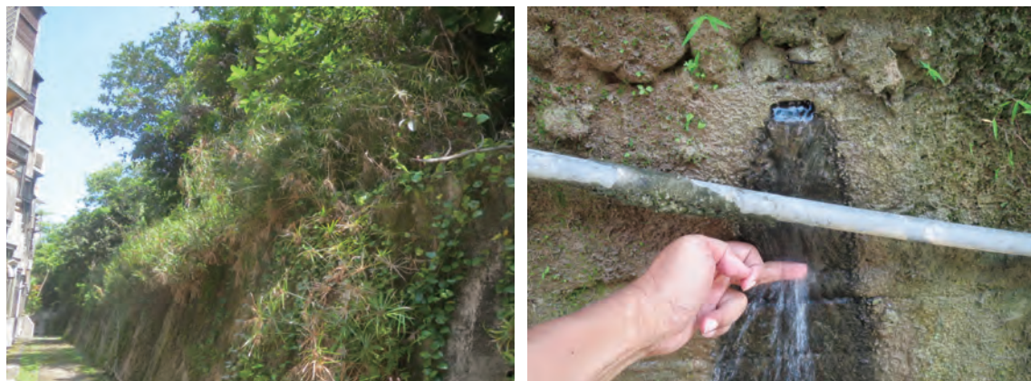
圖 5-4 中山大學職務宿舍 B 棟（壽山館）後方的擋土牆、濕地及泉水 資料來源：廖德宗 2017 年 5 月拍攝。
