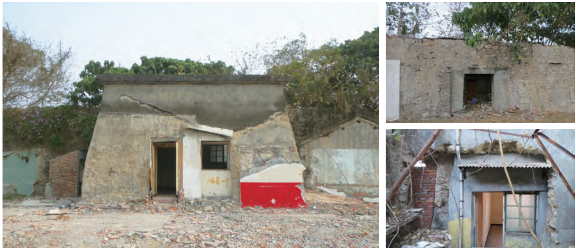
圖5-6 舊城西門砲臺及其後方之城牆內壁與外壁之洞，形成穿過城牆的通道（2014年2月拍攝）
