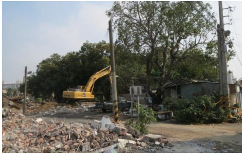
2014年2月西自助新村拆除作業
