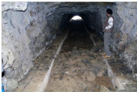
澎湖西嶼之震洋隊格納壕
