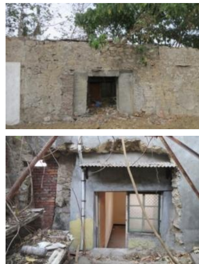
西門砲台及後方城牆內壁與外壁之洞，形成穿牆通道(2014年2月拍攝)
