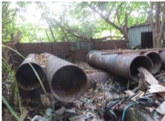
眷舍內11支昭和16年水管(2013.10)
