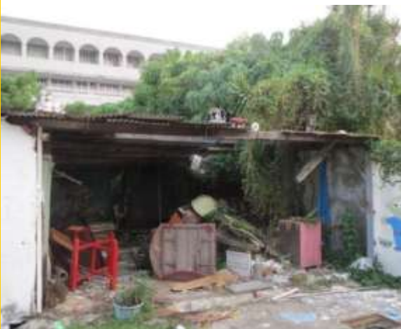
西自助新村待拆眷舍
